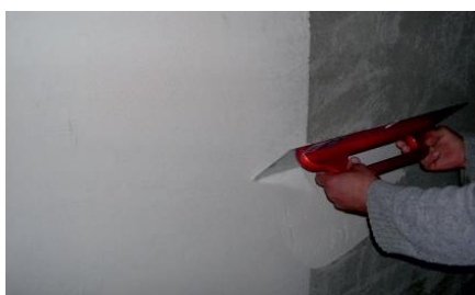
Primeiro barramento de SecilTEK PK 08
