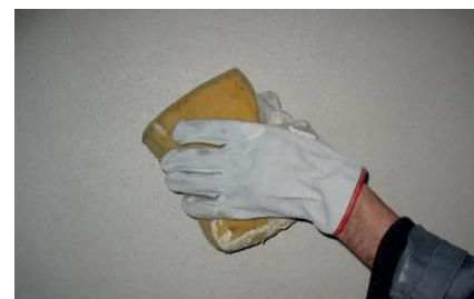
Execução do acabamento areado
