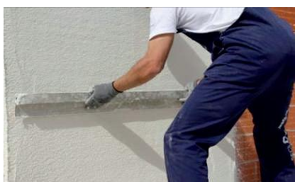
Regularização com régua metálica
