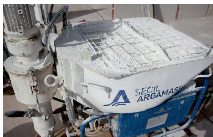
Amassadura do ISODUR
