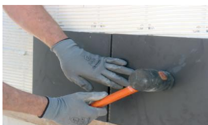
Assentamento com auxílio do maço de borracha
