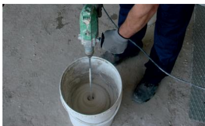
Amassadura do ADHERE Flex
