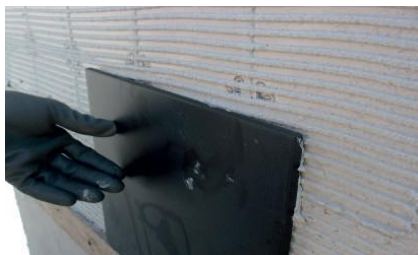
Colocação do cerâmico
