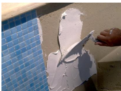
Espalhamento do ADHERE Piscinas sobre o suporte
