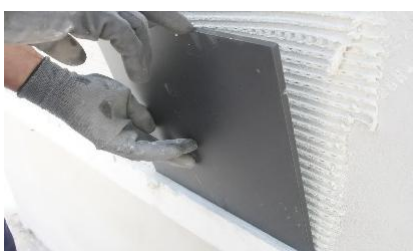
Colocação de cerâmico
