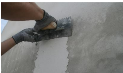
Espalhamento de ADHERE Clássico
