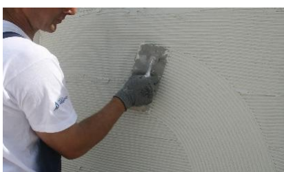
Regularização com talocha denteada
