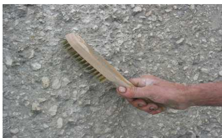
Remoção das matérias desagregadas
