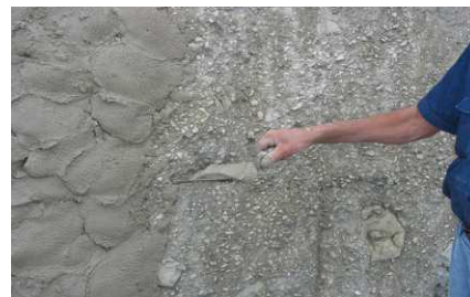
Aplicação manual do REABILITA BETÃO R2
