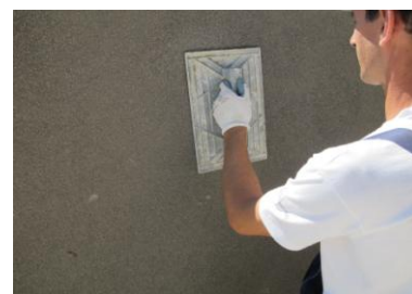
Talochamento da superfície final
