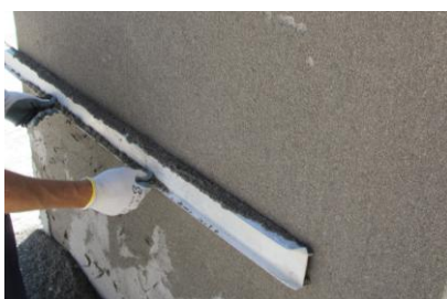
Regularização da superfície com régua
