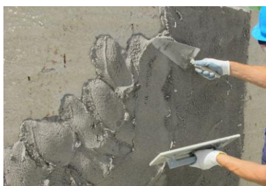
Aplicação manual do Secil ecoCORK Lime
