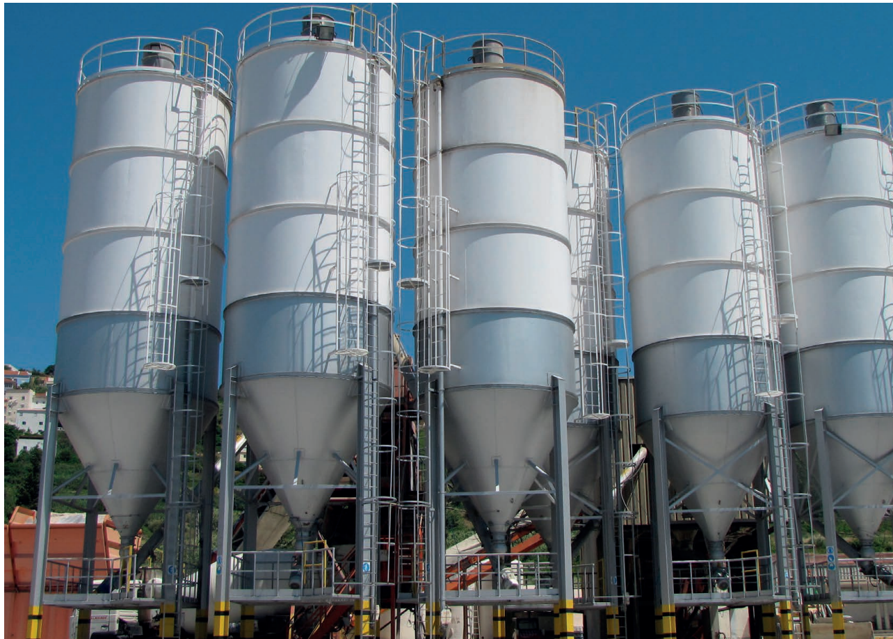
Central de Betão Unibetão, Frielas
